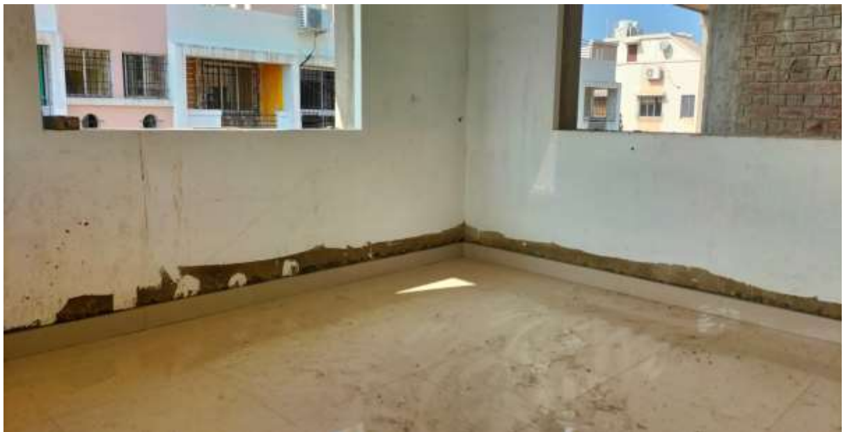
Floor Tiles work E1
